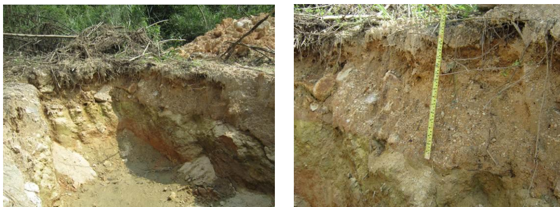
图 5.3-5 场区南东侧山坡 GZK4 监测井附近厚 0.2~0.5m 的残坡积层
