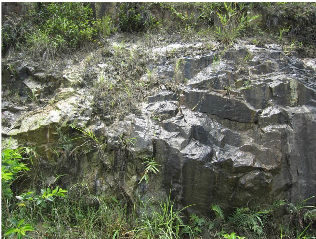
图 5.3-3 场区南东侧路壁上花岗岩中的节理构造（D026 点，镜向南东）
